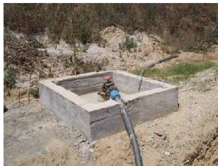
Фотографии од главата на бунарската конструкција
